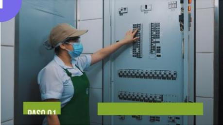
Desenchufa el equipo y apaga el equipo desde el tablero eléctrico.
