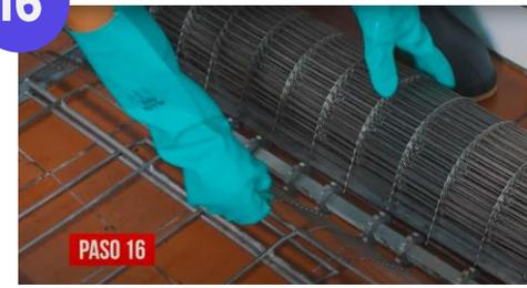
Armado de malla: Coloca el catre en la parte superior plana. Desenrolla la malla, coloca la parte áspera hacia abajo y la parte lisa hacia arriba.
