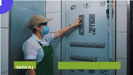
Desenchufa el equipo y apaga el equipo desde el tablero eléctrico.
