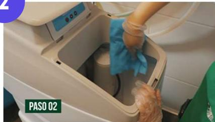
Levanta la tapa del tanque de almacenamiento y limpia sólo los lados de la parte interna con el paño de limpieza.
