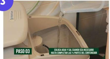
Coloca agua y sal cuando sea necesario hasta completar las ¼ partes del contenedor.
