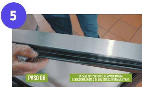
Revisa que todo el borde de la empaquetadura de la puerta esté en buen estado.
