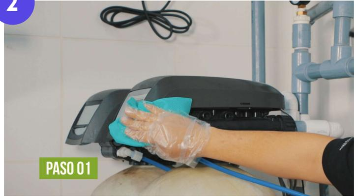
Limpia la parte externa del balón de almacenamiento con un paño de limpieza húmedo con desinfectante.
