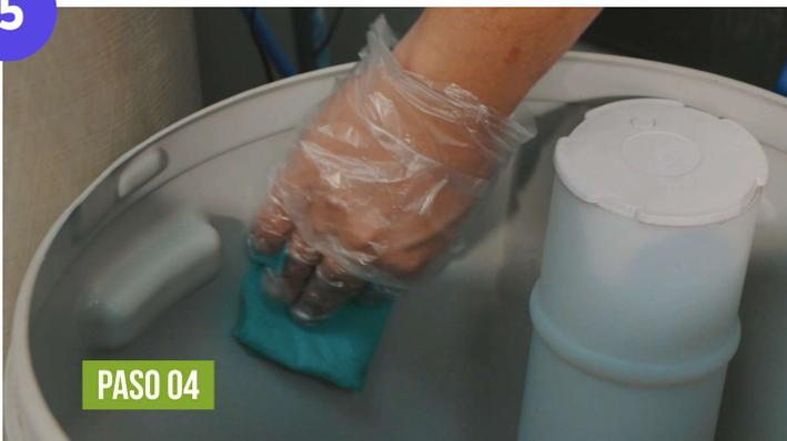
Si los lados internos del tanque están sucios, cierra la llave del agua y límpialos. El tanque debe estar vacío para hacer esto. Usa un paño de limpieza húmedo con desinfectante.
