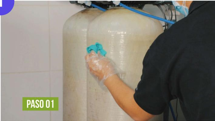
No desconectes el equipo. Limpia los balones de almacenamiento con un paño húmedo con desinfectante.
