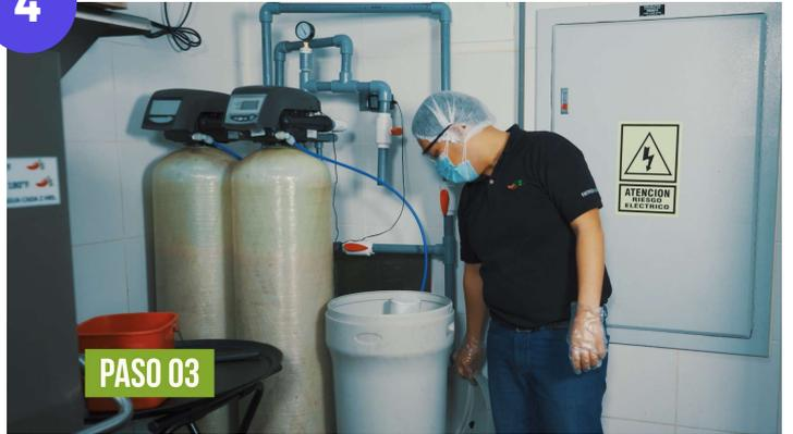
Valida si el tanque de almacenamiento tiene sal (debe tener  $\frac{1}{4}$  partes de sal). Llena el resto con agua al ras.
